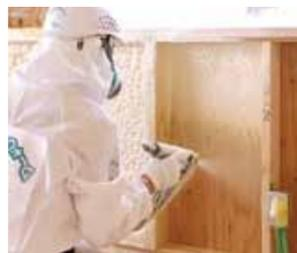
fig.07 腰壁への吹付け
