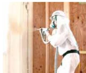
fig.08 壁への吹付け
