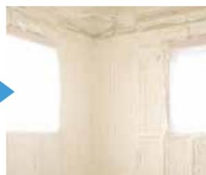
fig.06 吹付け施工後
