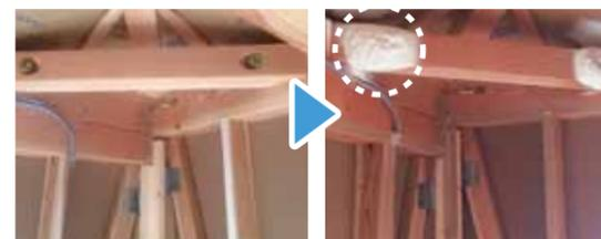
fig.11 熱橋金物となる金物 火打梁 fig.12 吹付け後
